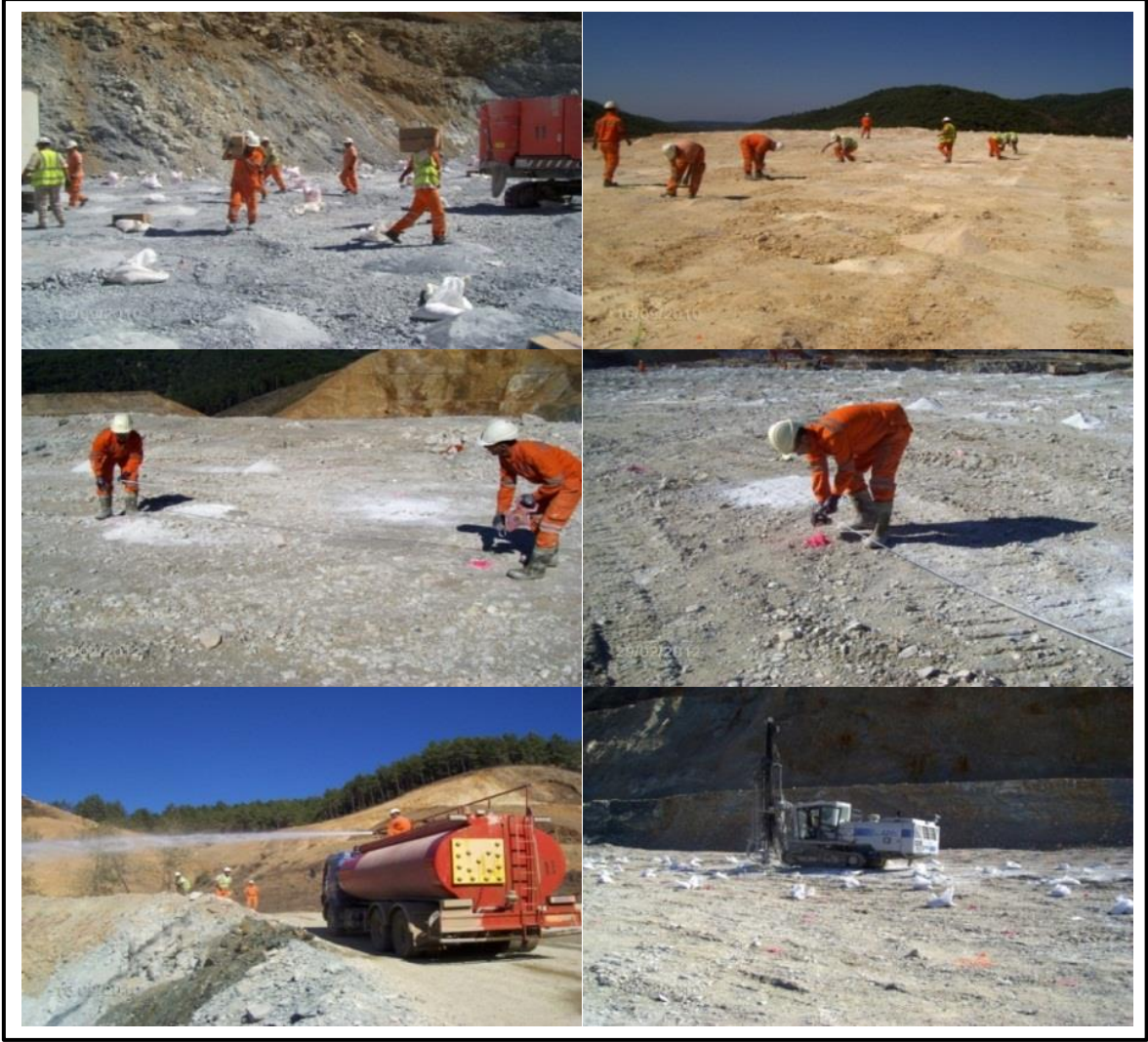
Şekil 65 Patlatma Hazırlık Aşamasını Gösterir Örnek Fotoğraflar
